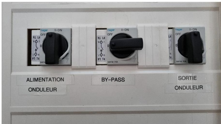
Figure 1 : fonctionnement normal en mode secouru
