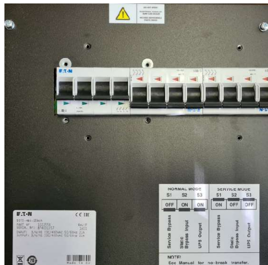
Figure: fonctionnement normal en mode secouru
